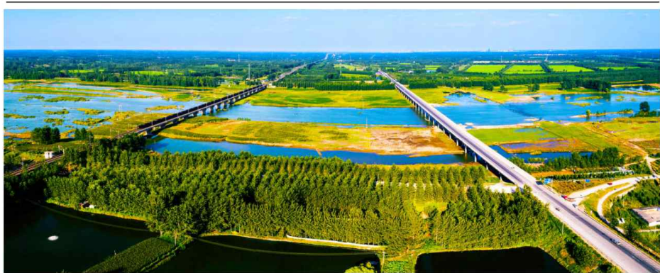
夏日的沂河,俯瞰沂河两岸,沃野千里,绿意盎然,一片生机勃勃的繁荣景象。图为在空中拍摄的沂河铁路、公路桥。(记者)
