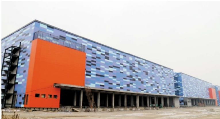
徐州北盟物流有限公司冷链物流项目新建设成,总建筑面积15.8万平方米,建设6座大型冷链物流仓库,总投资20亿元。于2015年开工建设,2018年部分工程已竣工投产。据了解,当前冷链物流设备全部完成订购完成,1-4号库保温施工已完成,5号库制冷设备安装完成,5-6号库主体结构正在施工,大架桥主体建设完工,幕墙安装处于紧张的施工状态。
