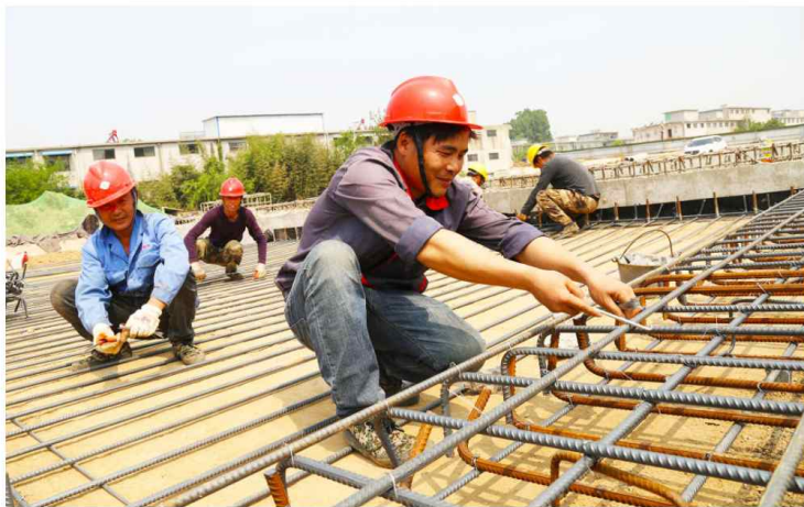
新东路(马陵山路至 G311 段)长约 0.9 公里,宽 46 米。内容包括道路、桥梁、雨污水管网、绿化、路灯等,按照海绵城市标准进行建设。目前,工程正在有条不紊地加快建设,预计于 10 月份实现通车。
