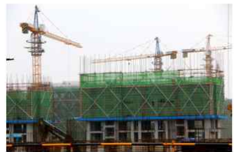
神井花园二期施工现场
