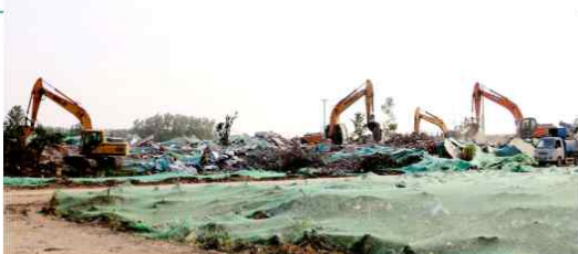
拆迁现场井然有序
