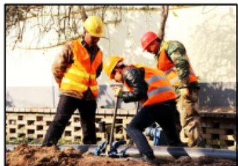
自来水管道铺设现场
