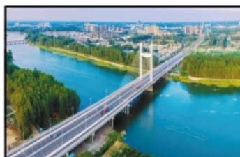
北京路沭河大桥
