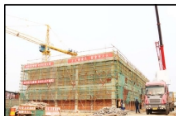
动物无害化处理施工现场
