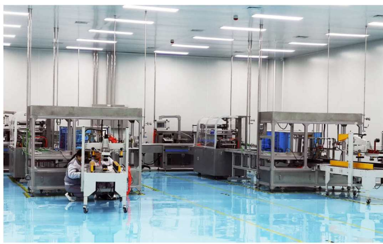
必康医药制剂研发生产项目包含九个制药车间,涵盖生物制剂、基因工程药物、眼科用药、无菌注射剂、膜过滤注射液、中药材提取、医疗器械、口服液以及片剂、胶囊、颗粒等固体制剂药物。项目借助大数据、云计算、物联网、人工智能等核心技术,以药物“智”造为统领,以制药工艺过程自动化为基础,以生产作业可视化、管理信息化、质量监控数字化等关键,项目建成后年产值可达60亿元。
